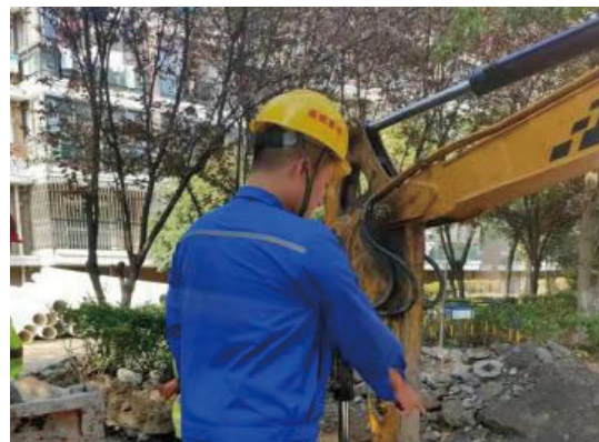
圖：現場監護人員監督開挖工作
