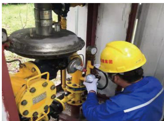
圖：巡檢人員檢查調壓設備
