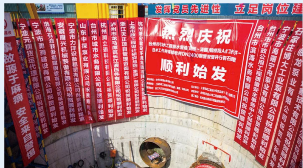
台州市引水工程—原水管道岩石頂管順利開啟頂管
