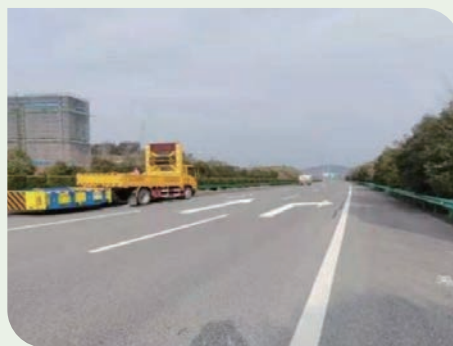
圖：更換交安設施
