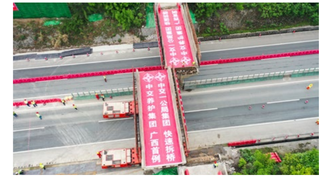
中交养护集团桥梁快速拆建成套技术达到国际领先水平，在柱 3 小时内拆除 2 座跨线天桥，全过程未中断交通，无粉尘、噪音污染
