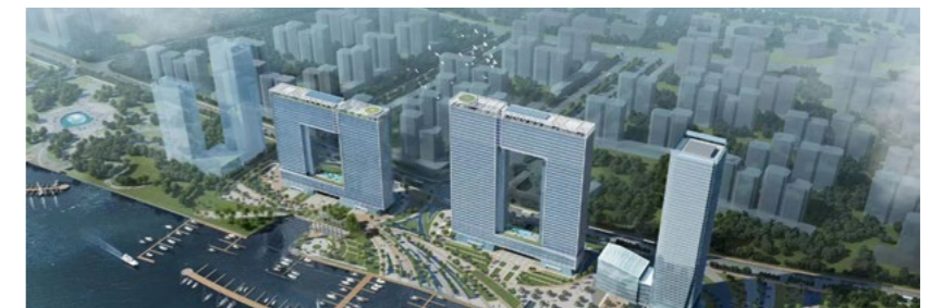
四航局中国交建南方总部基地项目，广泛使用节能新型建筑材料，有效减少材料和能源的损耗且维护成本较低，荣获“国际标准智慧园区示范区”称号
