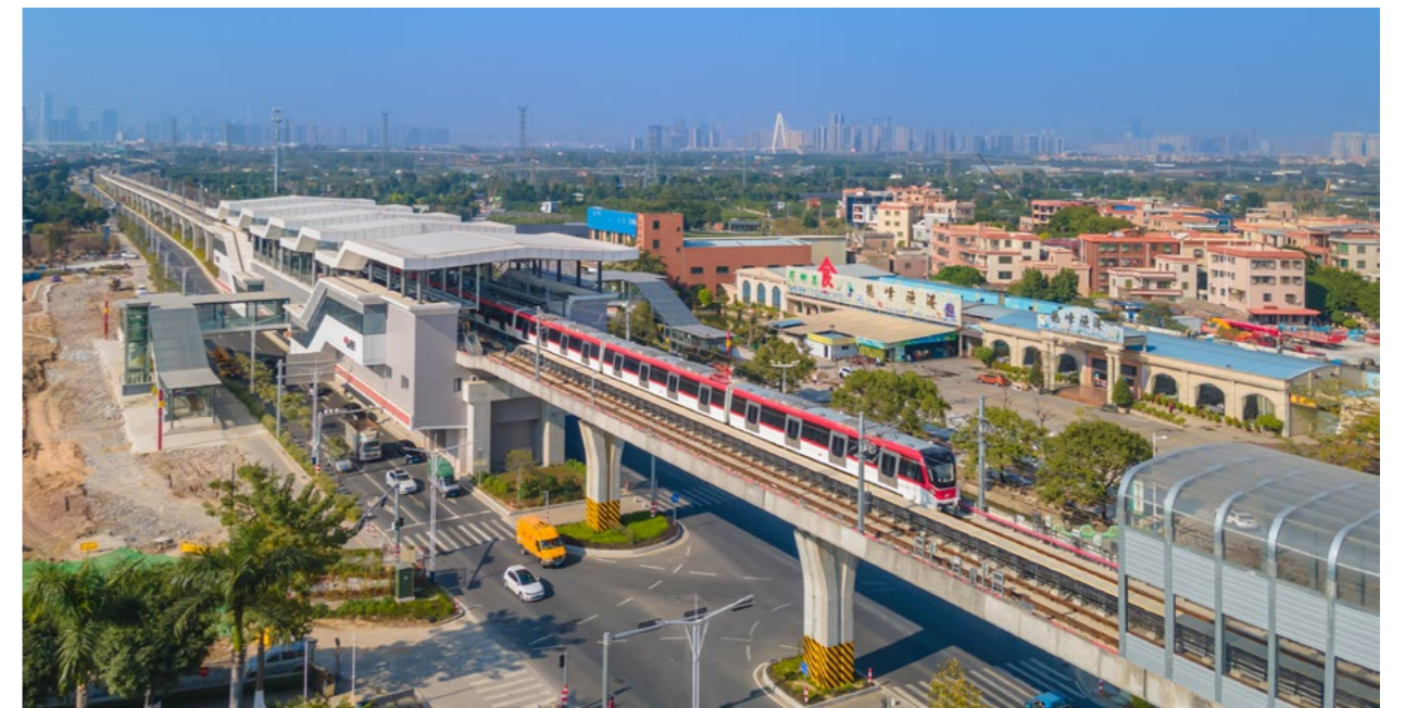
佛山地铁2号线一期工程
