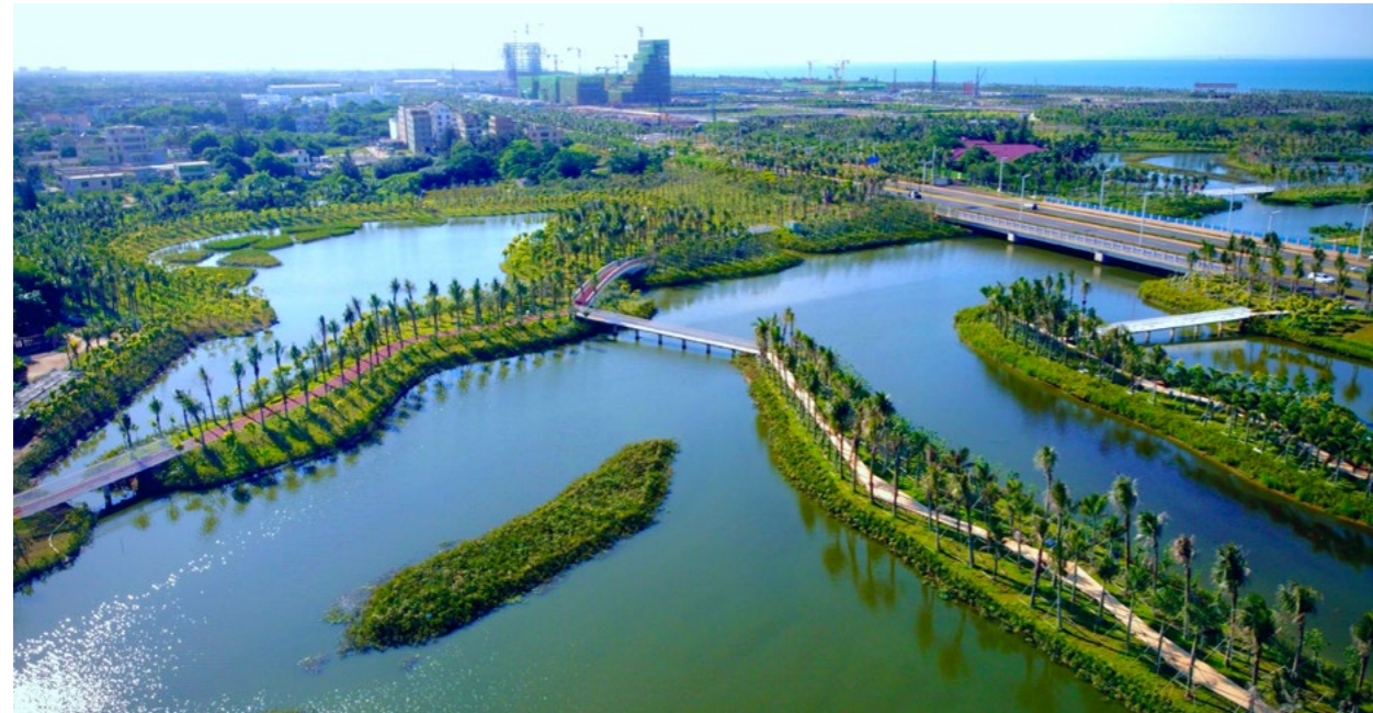
一航局海口市江东新区起步区水系（道孟河、芙蓉河）综合治理工程创新采用生物技术进行坑塘底泥处理处置，用于底泥堆肥、底泥填方、底泥制陶、底泥制砖，在美化环境防止二次污染的同时，带来了可观的经济效益
