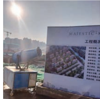
Fog gun on site 現場佈置霧炮
