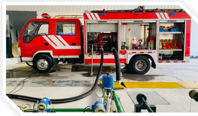
Fire pump depth test 消防泵吸深試驗
