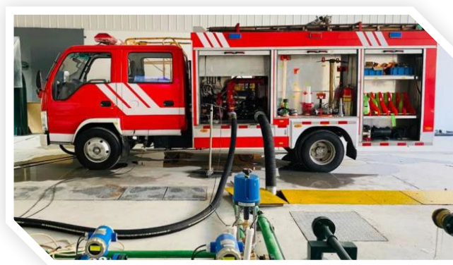
Fire pump depth test 消防泵吸深試驗
