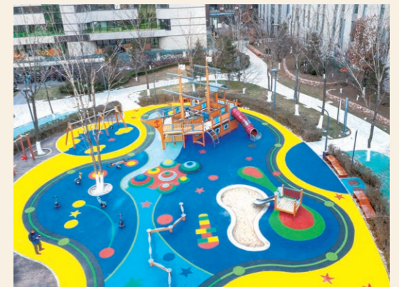
「皆樂園」翻新改造
