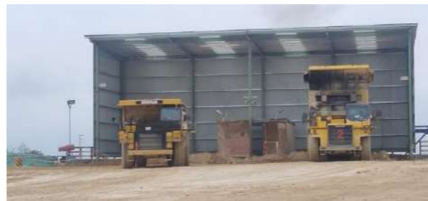
四川亚东破碎机卸料口封闭
