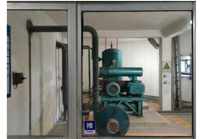
设置隔音控制室减少噪声污染
