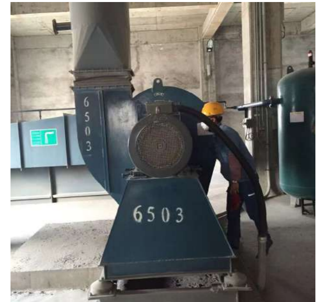
大噪声设备增加隔振及消声装置
