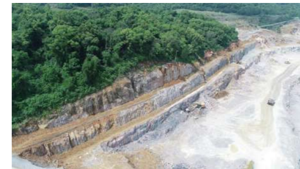
江西亚东矿区终了边坡实施预裂爆破, 维持岩体完整及稳定性
