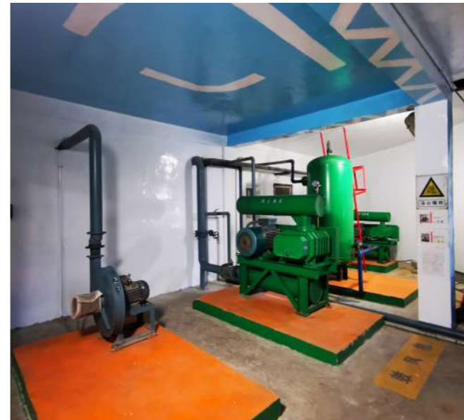
大噪声设备增加隔振及消声装置
