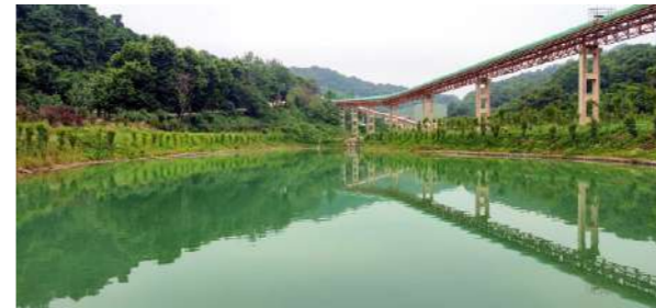
江西亚东二沉淀池
