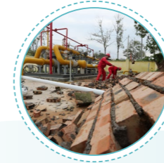
清理倒塌圍牆
