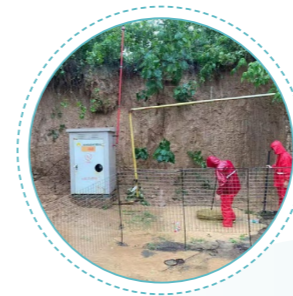
緊急處置關閉閘井
