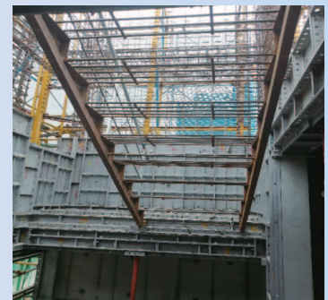
利用鋼筋餘料制作臨時爬梯
