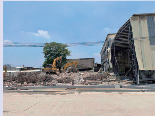
清拆低效工業廠房現場
