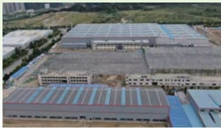
工業園分佈式光伏項目建設
