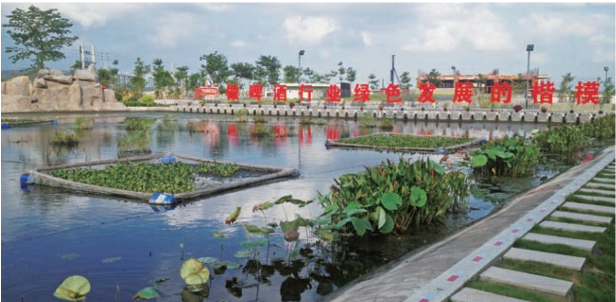
揭陽公司污水處理濕地
