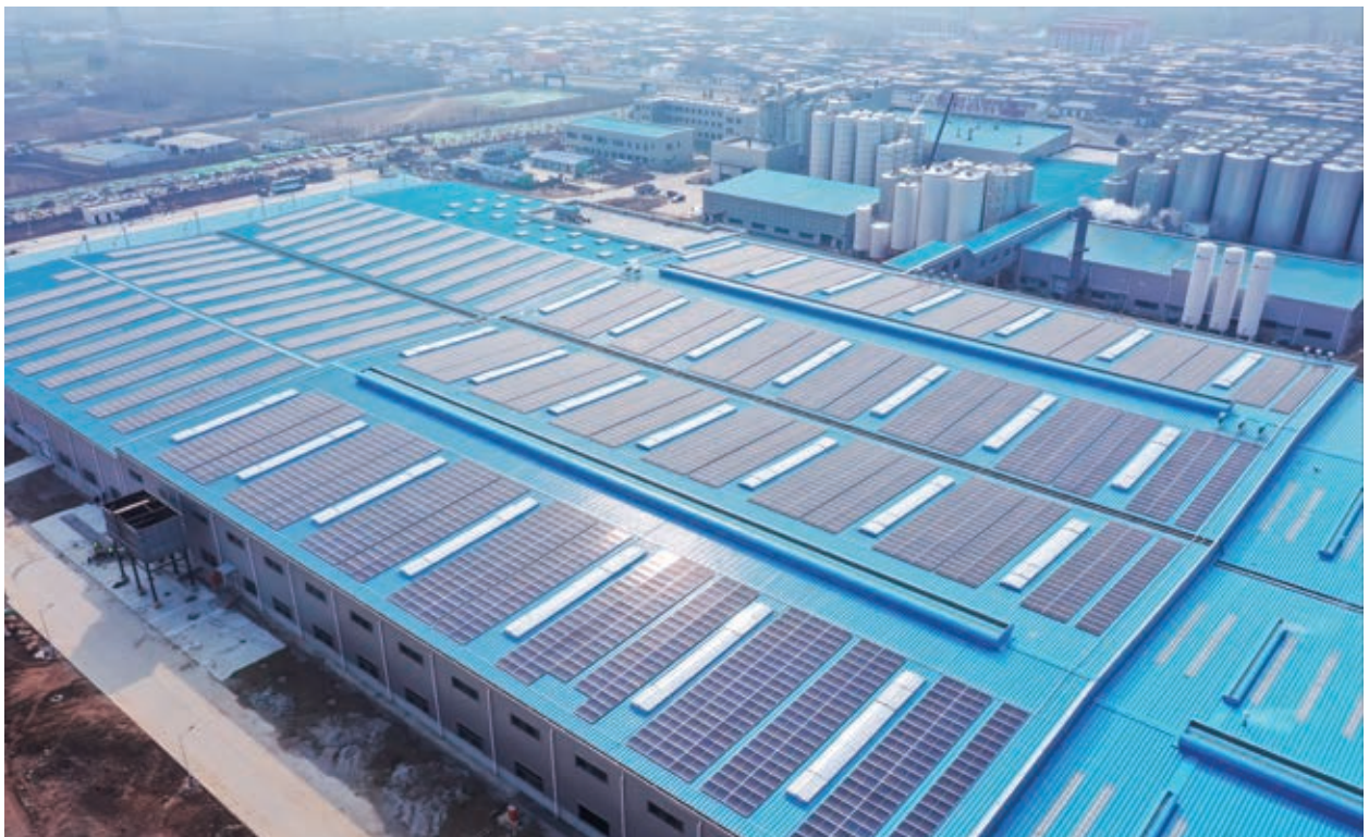
青啤棗莊公司安裝太陽能光伏板
