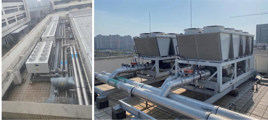
1期2期冷凍水系統併網改造，通過智能的控制來降低設備的總開機時間和總運行功率
