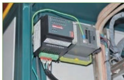
🔹 EBA水泵房設備運行監測系統
