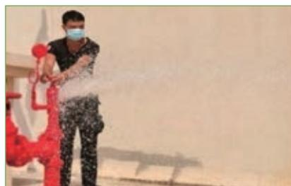
💧 屋頂試驗消防栓防水測試
