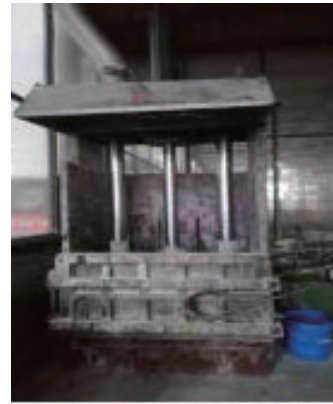
(將打包機安裝至密閉房間)
