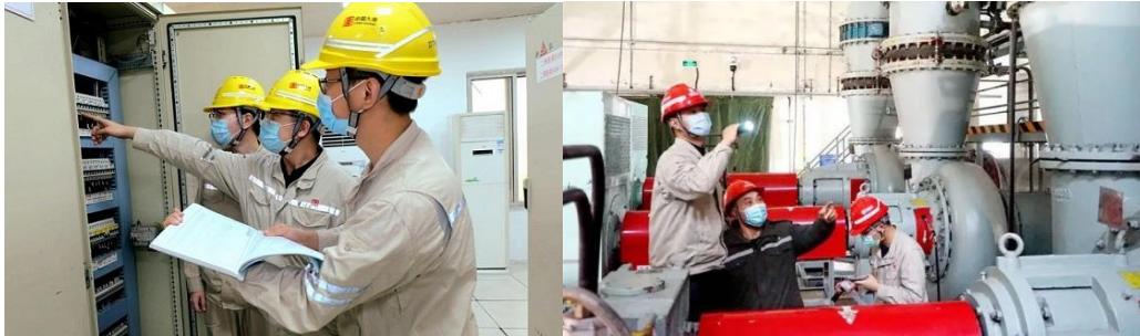
安全檢查現場
