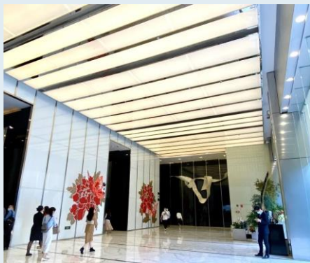
廣州盈凱廣場大堂LED燈帶更換
