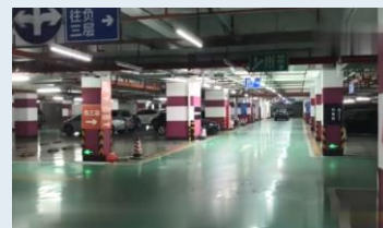
地下車庫照明系統改造
