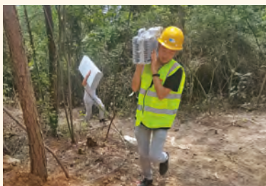
武隆貧困偏遠山區基站建設
