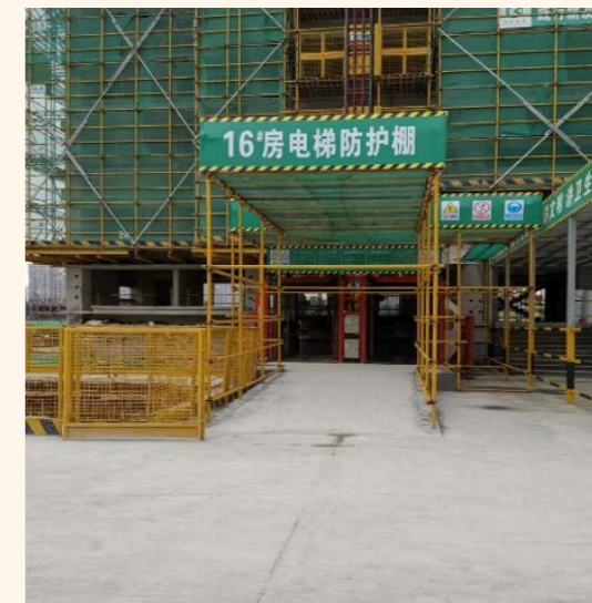
装配式电梯防护棚
