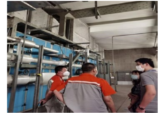
風機改造現場
