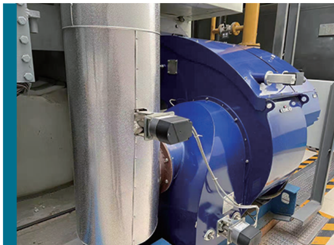
▲ 空調燃燒器更換
