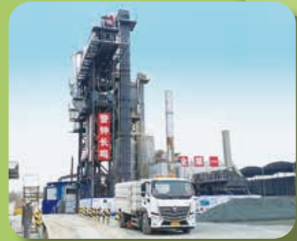
熱再生綠色養護工程
