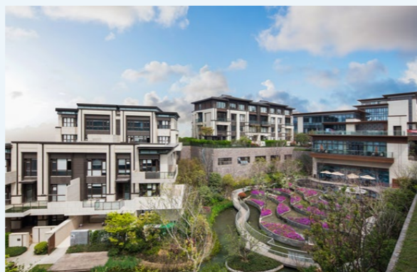
金隅紫京疊院 BBMG Zijing Dieyuan Project
