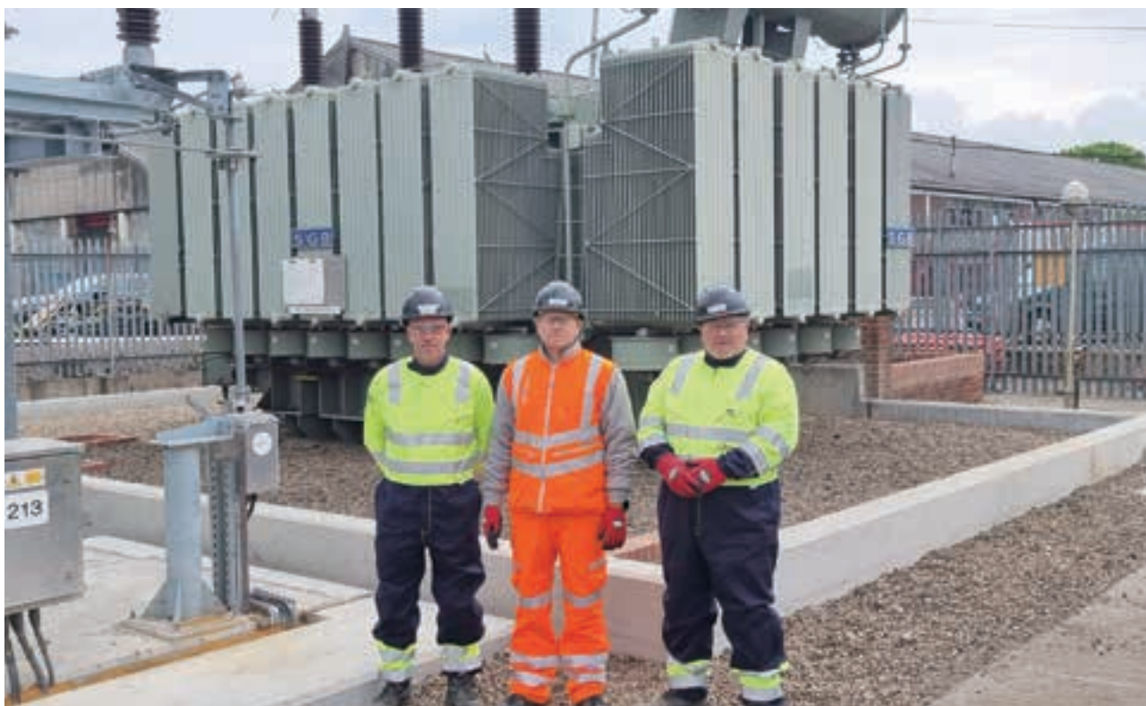
UK Power Networks 完成一項為數 500,000 英鎊的防洪計劃，為 69,000 戶家庭和企業提升電力供應的恢復能力。
