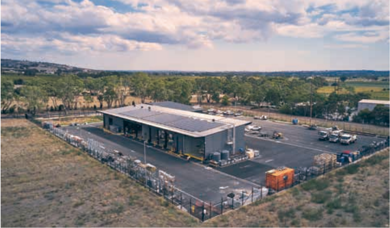
SA Power Networks 的最新倉庫 Angaston 已安裝了 94 千瓦太陽能系統
