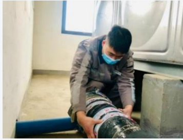
工作人員進行管道防凍作業
