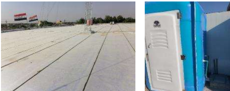
屋頂維修和移動廁所供應
