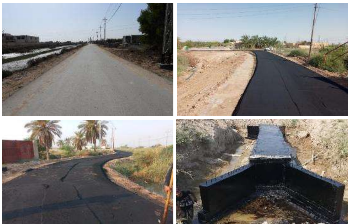
鋼橋、3 座箱形涵洞和 15 公里道路
