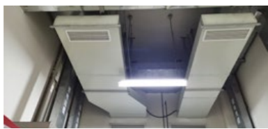
空調升級改造施工現場
