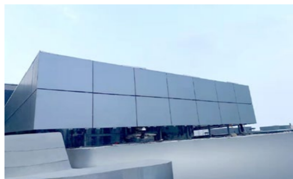
北京廣渠金茂府：採用灰色光伏牆產品 + 隱框光伏牆系統，裝機容量 3.4kW
