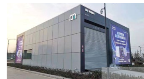
新鄭機場換電站
