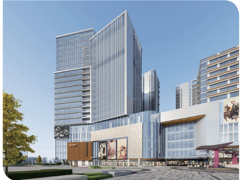
富豪國際新都薈之商業/寫字樓大樓(*)
