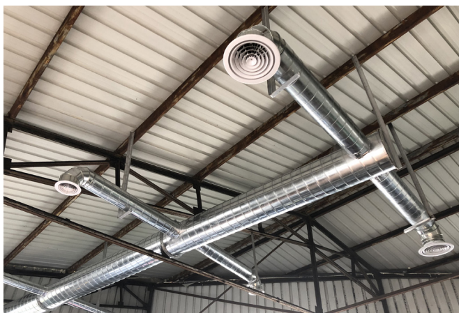
有害廢棄物處理裝置
