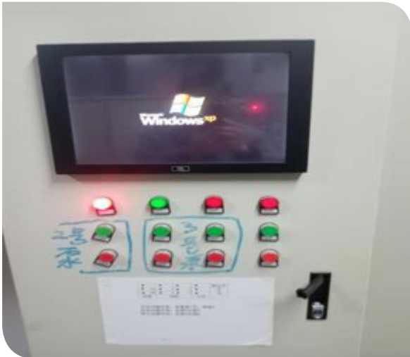
富豪金豐酒店在中央空調系統安裝了螺旋式水泵變頻系統，可節省50%或以上的電力消耗。
