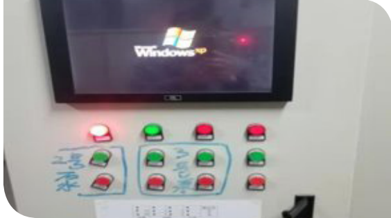
富豪金豐酒店在中央空調系統安裝了螺旋式水泵變頻系統，可節省50%或以上的電力消耗。
