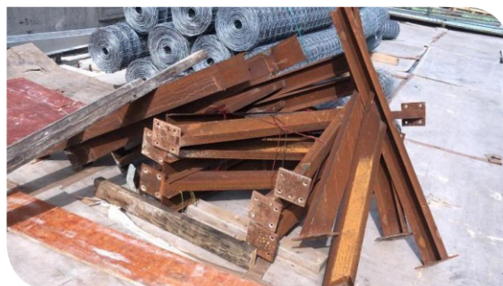
於建築地盤回收金屬再用
