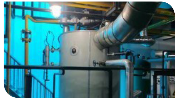
空港大酒店將鍋爐更換成能源效益更高的型號，節省了8%能源。
