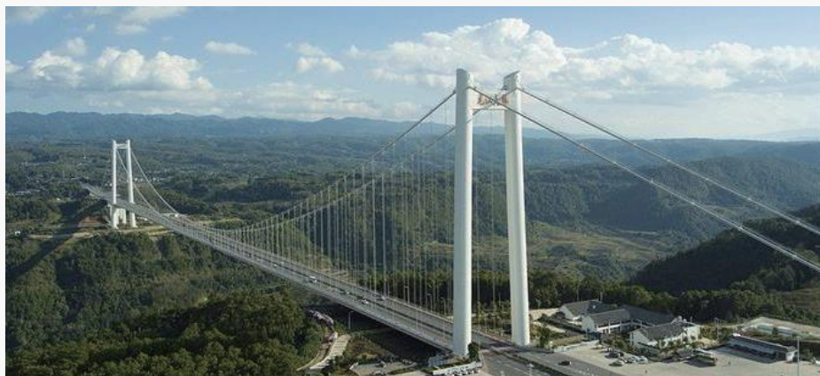
云南龙江特大桥
