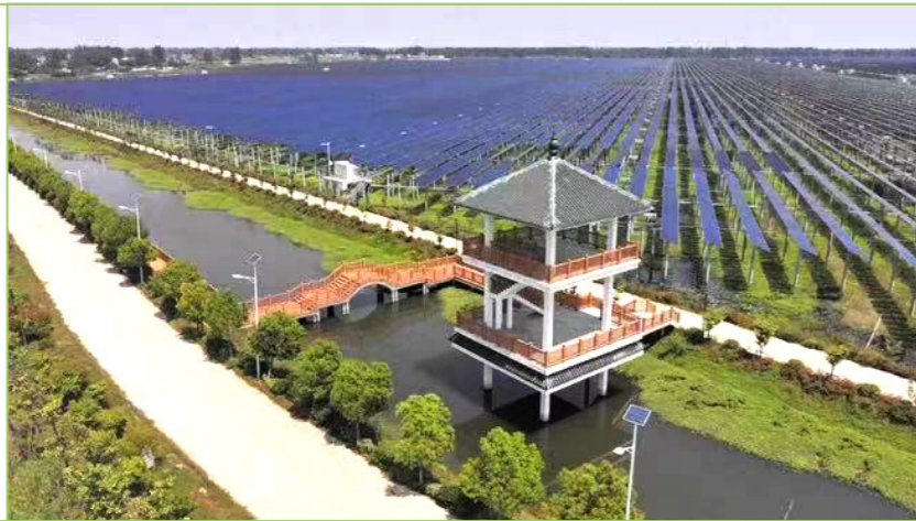
壽縣光伏電站
