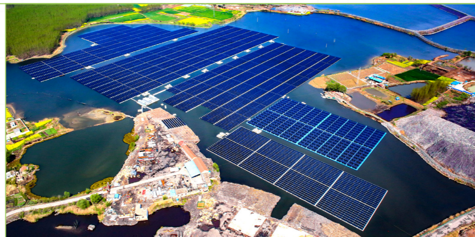
淮南光伏電站
