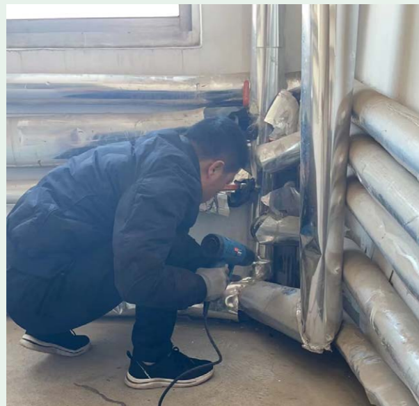
供水項目公司嚴寒天氣下對管道進行保溫化凍
