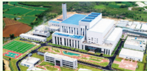
陸豐垃圾焚燒發電廠
