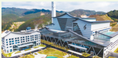
清遠垃圾焚燒發電廠
