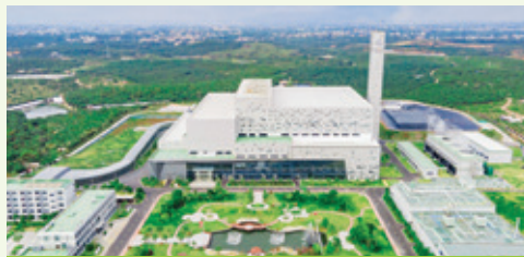
電白垃圾焚燒發電廠
