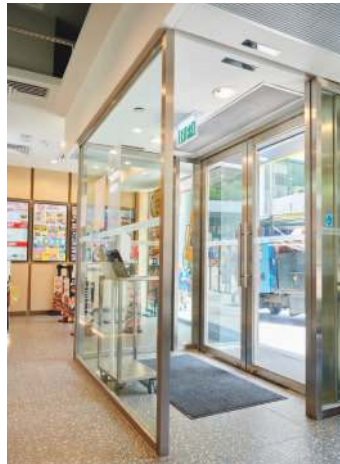
Air Lobby 空調大堂
