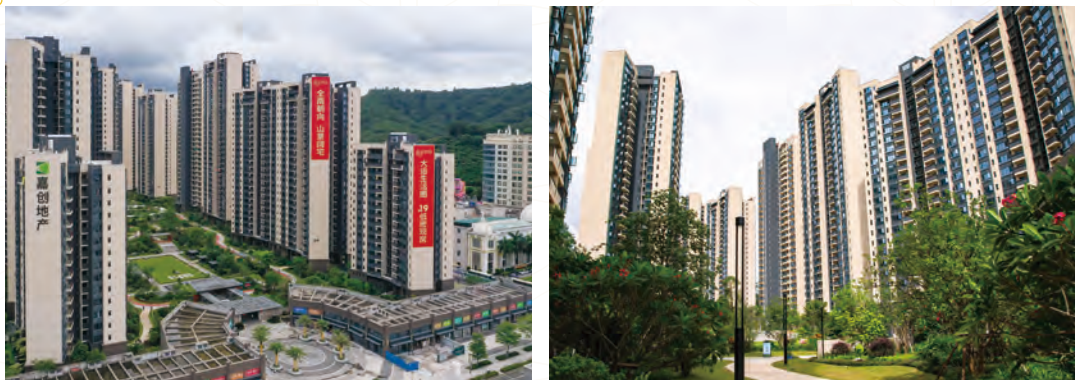
Actual view of Phase 4 & 5 of Castfast Villas 嘉輝豪庭第四及五期的實景圖
