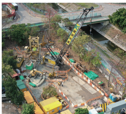
位於元朗洪水橋之地基打樁工程
