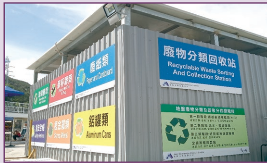
Waste Sorting Stations 廢物分類站
