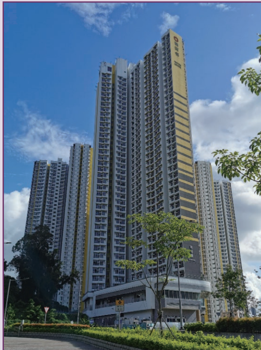
One of our substantial contracts – Construction of Public Housing Development at Tuen Mun Area 54 Site 1 & 1A 我們的重大合約之一 – 屯門第54區第1及1A地盤的公共房屋發展建設
