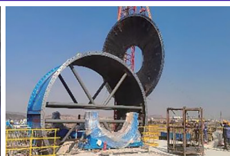
中區—磨礦車間—半自磨筒體安裝
