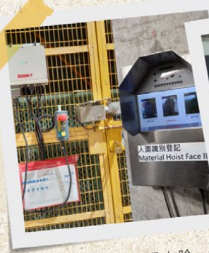
安全物料吊重機應用人臉辨識與電磁鎖定系統
