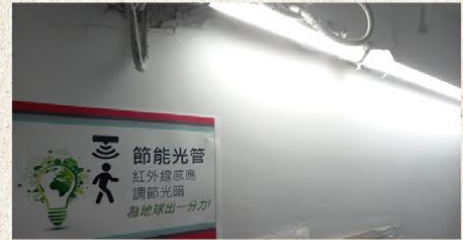
附運動傳感器之地盤 LED照明
