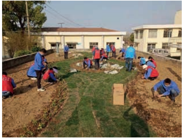
武漢市新洲區長源供水有限公司在進行清水池頂部綠化
