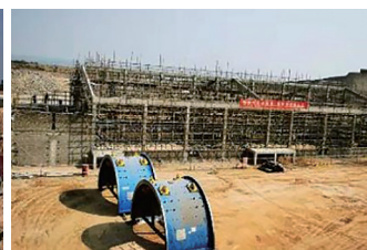
中區—磨礦車間—33KV配電室
