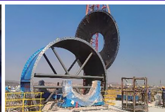
中區—磨礦車間—半自磨筒體安裝
