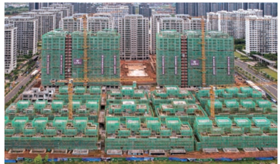
海口北辰府施工現場
