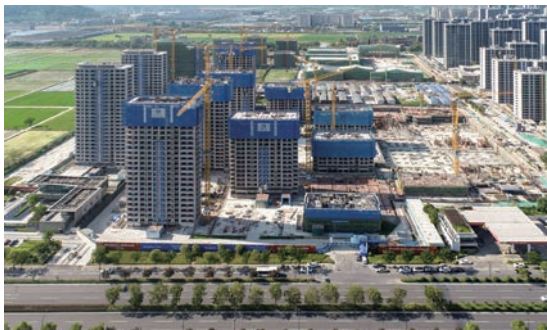
杭州北辰辰春瀾城施工現場
