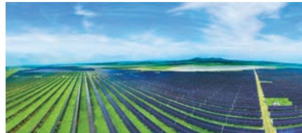
沽源「光伏+」示範項目
