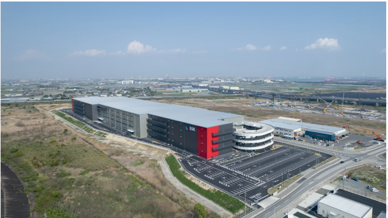
日本ESR彌富木曾岬町配送中心
