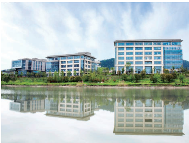
長沙億達中建·智慧科技中心
