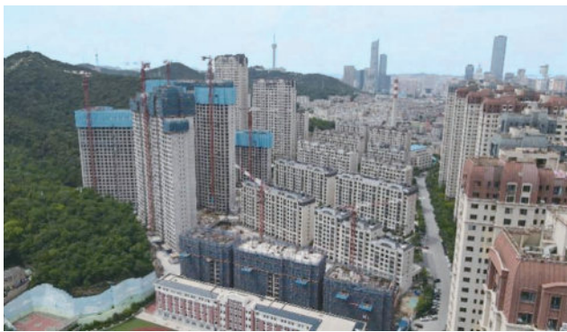
大連青雲天下項目施工現場
