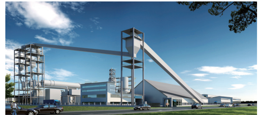
遂寧安居碳酸鋰工廠(在建)
